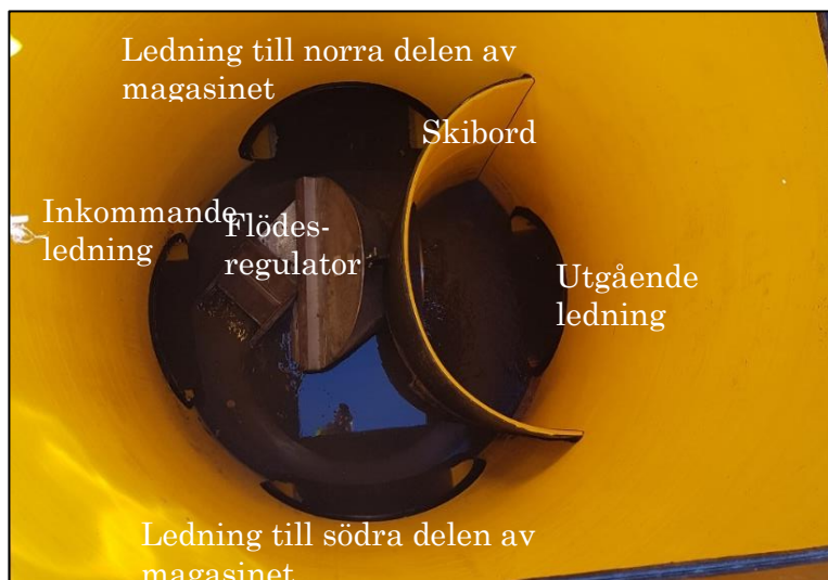
Figur 2. Fördelningsbrunn med flödesregulator och skibord
