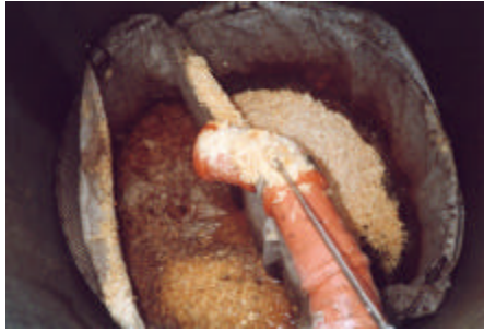
Figur 23. Olika typer av filterenheter för avskiljning av fekalier från vattentoalett – Dubbletten fekaliekompostavskiljare (foto: Ebba af Petersens) och Kaggen 20 .
