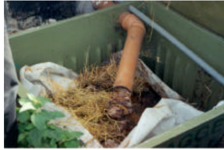
Figur 23. Olika typer av filterenheter för avskiljning av fekalier från vattentoalett – Dubbletten fekaliekompostavskiljare (foto: Ebba af Petersens) och Kaggen 20 .
