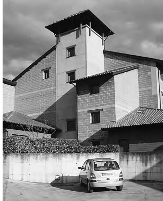
Fig 5.31. Tornbyggnaden i Domanie de la Terre följer regionens arkitekturtradition. Byggnaden är utformad av arkitekt Jean-Vincent Berrottier och är byggd av cementstabiliserad formpressad lersten. Det fem våning höga tornet är uppfört i stampad lerjord.
