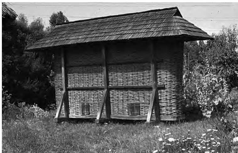
Fig 2.1. Korgflätad majstork från friluftsmuseet i Uzhorod, västra Ukraina. Slanorna kan "vävas" i olika mönster. Träspån på taket.
