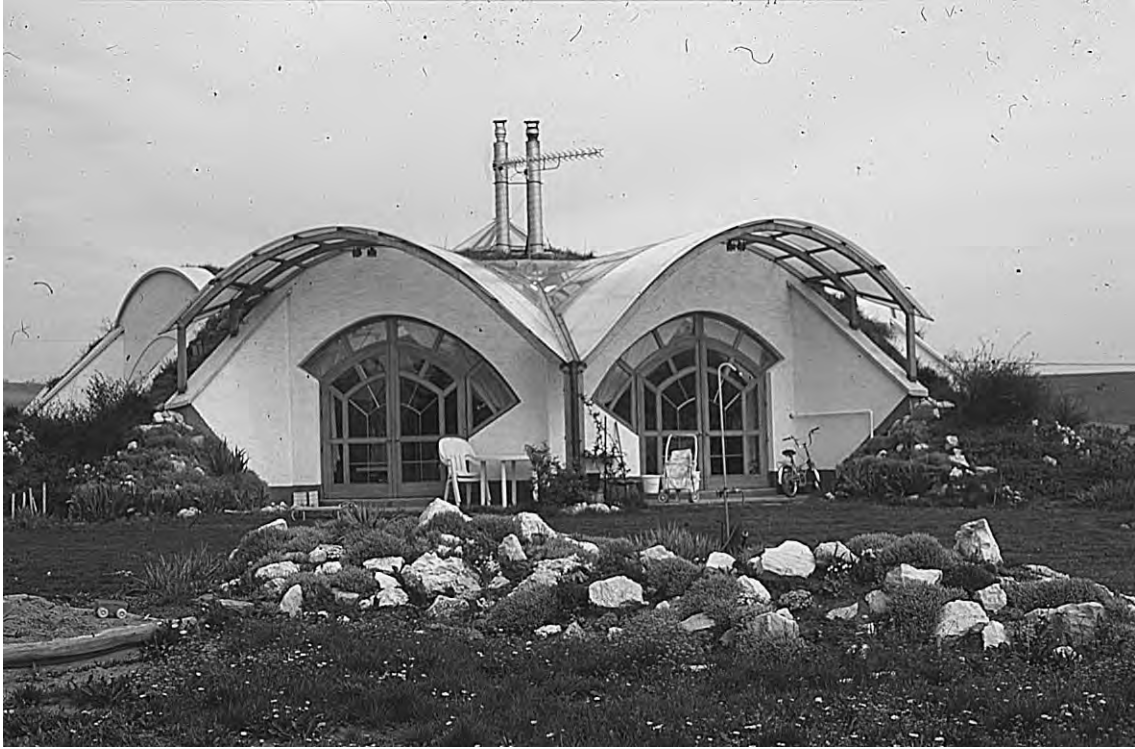
Fig 5.25. Kupolhus utanför Budapest ritat av arkitekt Zsolt Hegedüs.
