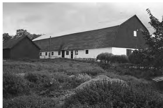
Fig 3.7. Ladugården vid Wiks slott i Uppland som uppfördes 1799. Leran till byggnaden hämtades troligen där den nu igenvuxna dammen i förgrunden finns.
