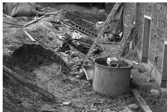
Fig 4.31. Leran till lerhalmsvägg och puts fanns tre meter från tillredningsplatsen.
