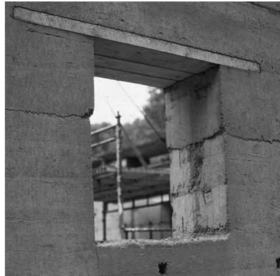
Fig 4.4. Över fönsteröppningen har kraftiga brädor placerats för att föra ner taklasterna vid sidan om fönstret. Här har horisontell formsättning praktiserats, vilket framgår av de fyrkantiga öppningarna i väggen. I fönsteröppningen syns en tydlig horisontell fog efter formskiftet.
