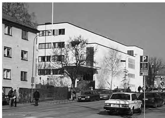
Fig 6.8. Tekniska högskolans kårhus, ritat av Sven Markelius och Uno Åhrén, har betongens formspråk men är byggt av tegel.
