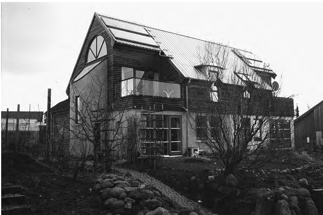
Fig 5.7. Sista husen i bogrupp 1 uppfördes med förtillverkade formpressade lerstenar. Alla byggnader i bogruppen utrustades med solfångare.
