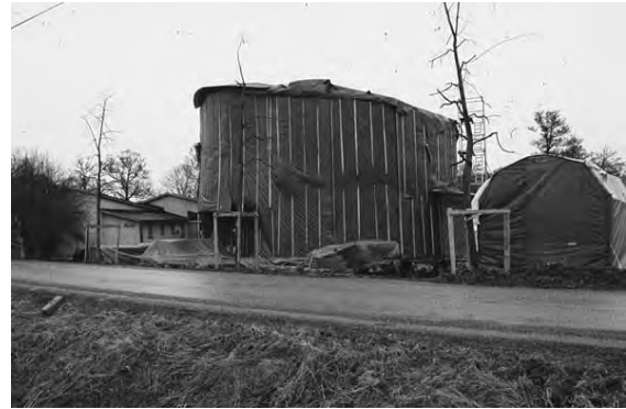
Fig 4.14. För att skydda de uppförda träväggarna mot vinterns regn och snö packades de in i plast.
