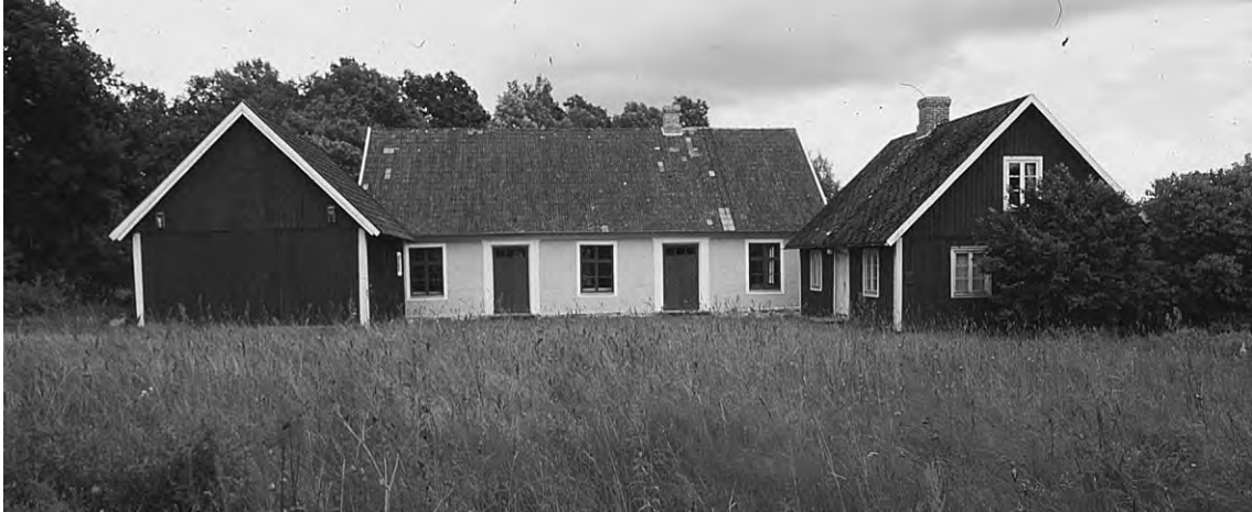
Fig 3.13, 14. Perstorp, Sveriges första baptistkapell från 1860 är ett stampjordshus som nu är byggnadsminnesförklarat.
