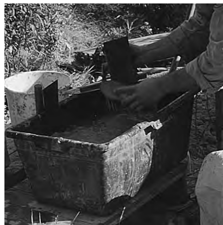
Fig 6.2 Här diskas ett bräde som använts för lerputsning. Till rengöring av redskap och verktyg krävs inga starkare rengöringsmedel än vatten.
