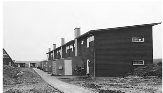
Fig 5.10. Mot norr är fasaderna slutna. Ventilationen bygger på självdrag som förstärks sommartid med hjälp av en solfångare i skorstenpipans övre del. Genom att värma upp luften i pipan skapas undertryck i byggnaden även under den varma delen på året, då självdragsventilation vanligen inte fungerar.
