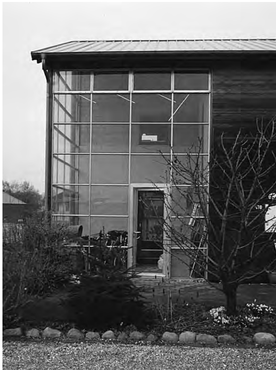
Fig 5.8. Hyresradhusen har byggts med växthus som förlänger växtsäsongen och som genom tunga material i golv och väggar passivt tillvaratar solvärmens vår, vinter och höst.
