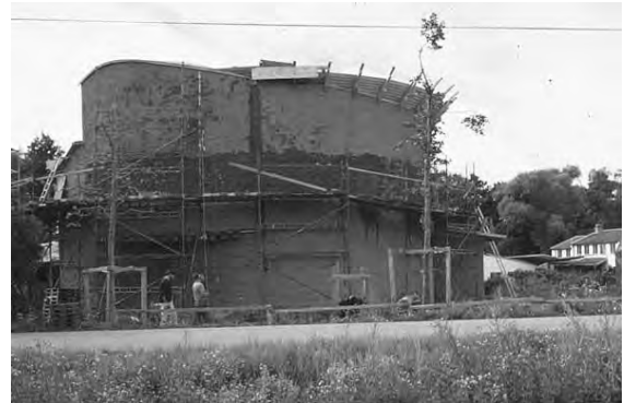
Fig 4.12. Kyrkans norrfasad mot byvägen under byggtiden, augusti 1999.
