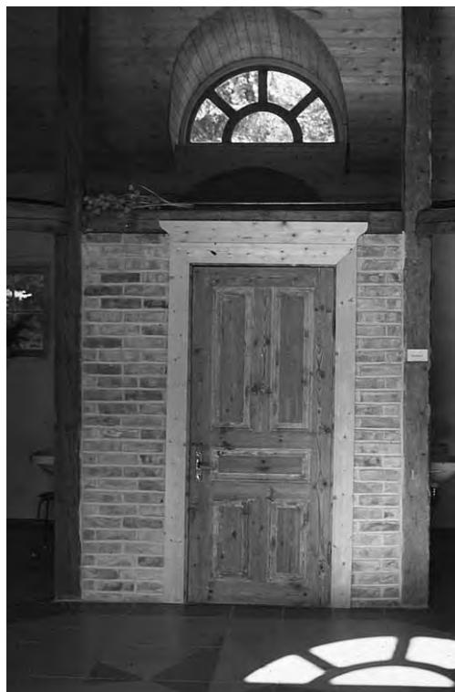
Fig 4.7, 8. Samma utrymme med ett års mellanrum. De kraftiga stolparna som bär upp den separata takkonstruktionen har tjänat som virke i den gamla, numera rivna, teatern i Falkenberg. Även teglet, som använts till en del av innerväggarna, kommer från samma byggnad. Detta är nog STF:s finaste sanitetsanläggning då denna och passagen till huvudbyggnaden också tjänar som konstgalleri.
