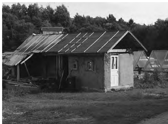
Fig 3.16. Servicebyggnaden vid Skärkälls andelsförening under återuppbyggnad efter en brand som slukade byggnadens brännbara delar.
