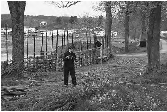
Fig 4.33. Anläggningen inhägnades med ett staket av energiskog (salix). Slanorna ansas innan de används till flätningen.
