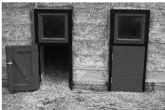
Fig 4.30. Specialritade fönster och dörrar, vars karmar skruvats fast i de vertikala regler som hållit klätterformen på plats vid uppförandet av lerhalmsväggen.
