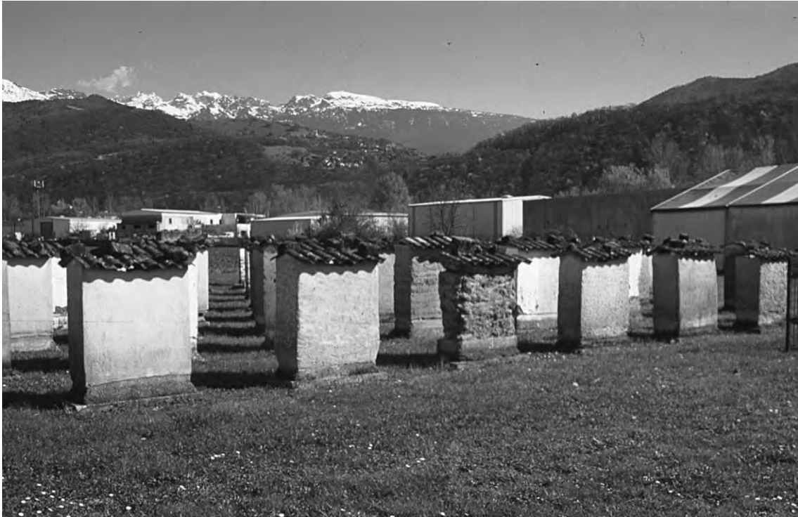
Fig 5.29. Vädrets påverkan på lerjordsväggar med olika ytbehandling studeras vid en provningsanstalt i Grenoble.
