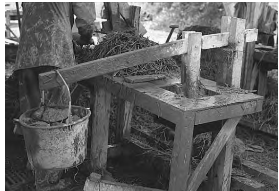
Fig 4.16. Tillverkningen av lerhalmsblocken skedde vid ett enklare pressbord.
