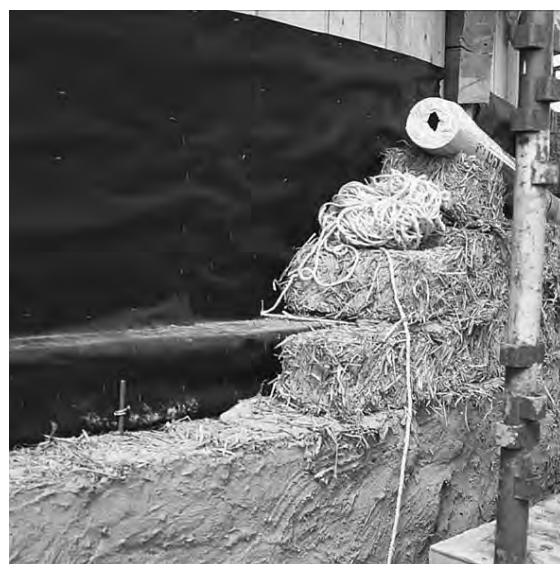
Fig 4.19. Lerhalmsblocken murades upp runt kyrkorummets stående plank med förhydringspapp emellan. Vissa skift förankrades med rep av sisal. Blockens första lager av grovputs lades på i samband med murningsarbetena. De sprickor som uppstod fylldes igen när det andra lagret grovputs av lera lades på väggen.
