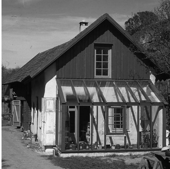
Fig 5.3. Det år 1997 uppförda arkitektkontoret på Tjørne. Huset består av en ramverkskonstruktion av trä med utvändig isolering av halmbalar, som putsas med lerputs, samt golv av lera och sand.
