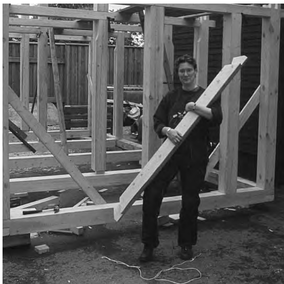
Fig 4.34. Få arbetsmoment i en ramverkskonstruktion kräver mer än ett par händer eftersom trä är ett lättviktigt material. Dimensionerna kan dock göra att "pinnarna" blir svåra att greppa.
