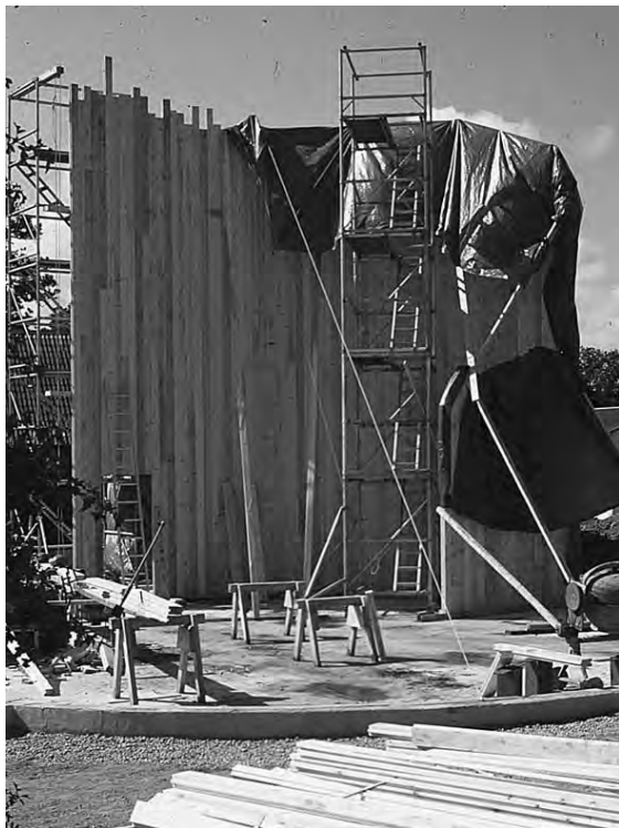
Fig 4.15. De 8 - 9 meter höga stående planken börjar ge kyrkan dess form.
