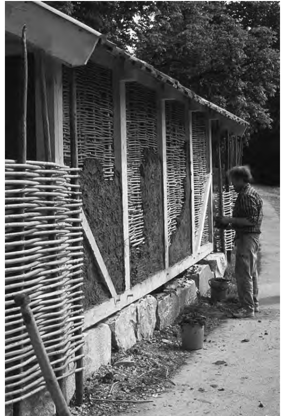
Fig 4.39.. Lerklining pågår på Härjarö campings minigolfbanas kiosk.
