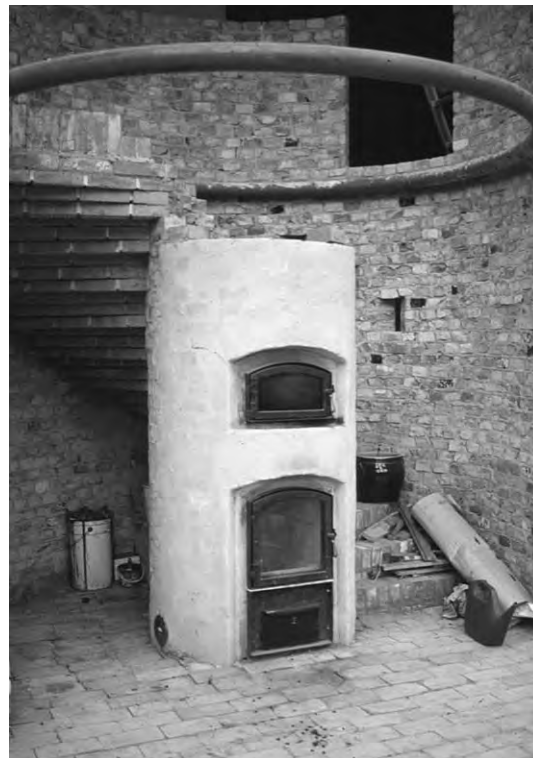
Fig 4.27. Anläggningens nav, den tre ton tunga massugn uppfördes under en kurs sommaren 1999.
