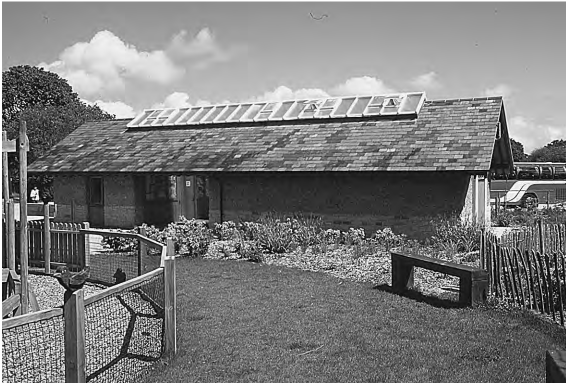
Fig 5.43. Den nybyggda servicebyggnaden vid Norden Park and Ride i Dorset.
