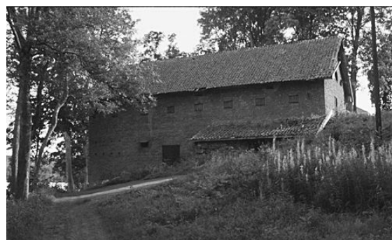
Fig 3.10. Spannmålsmagasin vid Gudhammars Herrgård. Lersten med stor inblandning av sågspån och träflis har använts till ytterväggarna. Dessa är dock inte bärande, taket bärs upp av en ramverkskonstruktion.
