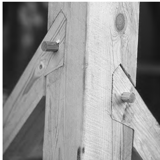
Fig 4.35. En hörnstolpe med två dymlade laxstjärtar. Dessa får inte "landa" på samma höjd.
