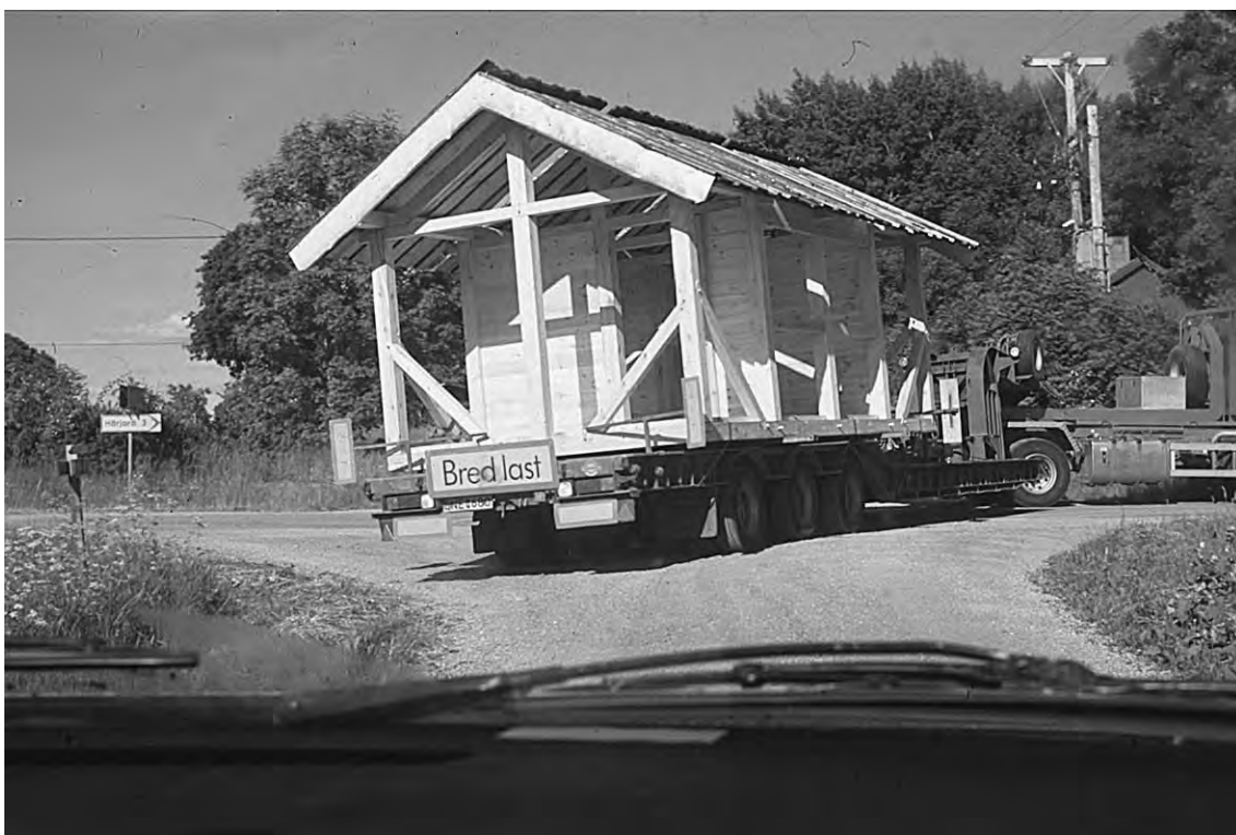
Fig 4.36. Hus på väg! Den hopfogade ramverkskonstruktionen kördes på en trailer till sin slutliga destination vid Härjarö minigolfbana.
