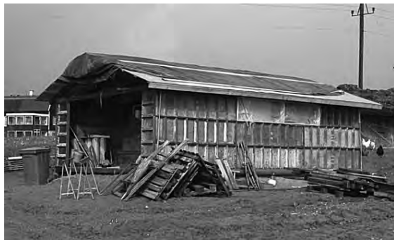
Fig 5.12. I ett kretsloppssamhälle kan allt återanvändas på ett eller annat sätt. Stampjordstekniken var för arbetsintensiv för tillverkning av väggar. Stampformarna får nu istället tjäna som väggar i det nya hus som uppförs för de äggproducerande hönsen.
