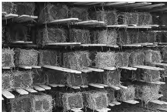
Fig 4.17. Några av de drygt 7 000 lerhalmsblock som tillverkades till kyrkbygget.
