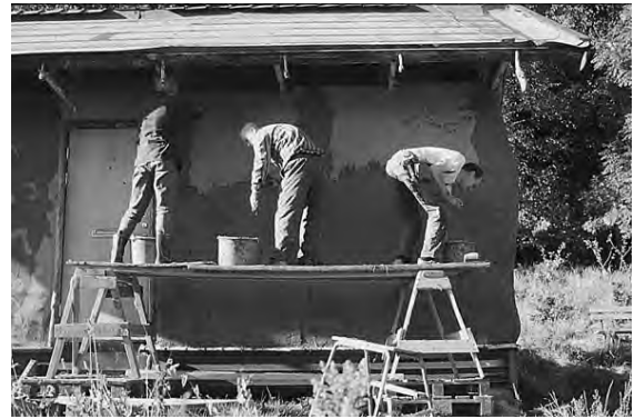
Fig 6.5. Arbetsgille. Finputsning på ett halm-balshus vid Ekocentrum i Göteborg. Arbetet gjordes av 5 - 6 personer på ungefär 6 timmar.
