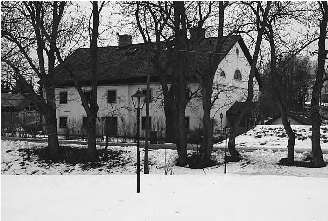
Fig 3.8. Svalbo, eller Jerlestugan, med arbetarbostäder som uppfördes av valloner i Järle under 1700-talets senare hälft. Troligen har leran som grävts ut för källaren använts för tillverkningen av stenarna i väggarna.
