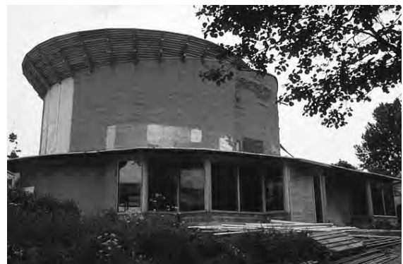
Fig 4.13. Kyrkans sydfasad där olika färger och putssammansättningar provats, försommaren 2000.
