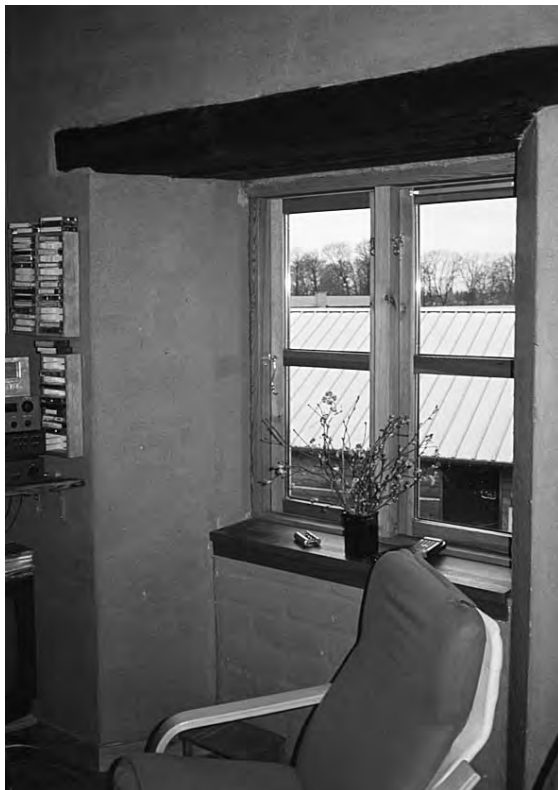
Fig 5.5. Ett av de första husen som uppfördes i Andelssamfundet i Hjortshøj byggdes som ett mindre kollektivhus för två familjer, men är nu ombyggt till två lägenheter. Ytterväggarna är uppförda av 500 mm stampad lerjord med cellulosafiberisolering och träpanel. Det parabolformade valvet i markplanet är byggt av tegel. De långa fönstren längst ut på fasaderna är solväggar. Soliga dagar värms väggen bakom glasrutan upp och den förvärmade luften förs in i byggnaden genom ett reglerbart spjäll.
