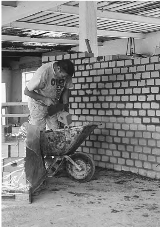
Fig 6.6. Konventionell murning av innerväggar med lersten vid ombyggnadsarbeten i en fabriksfastighet.
