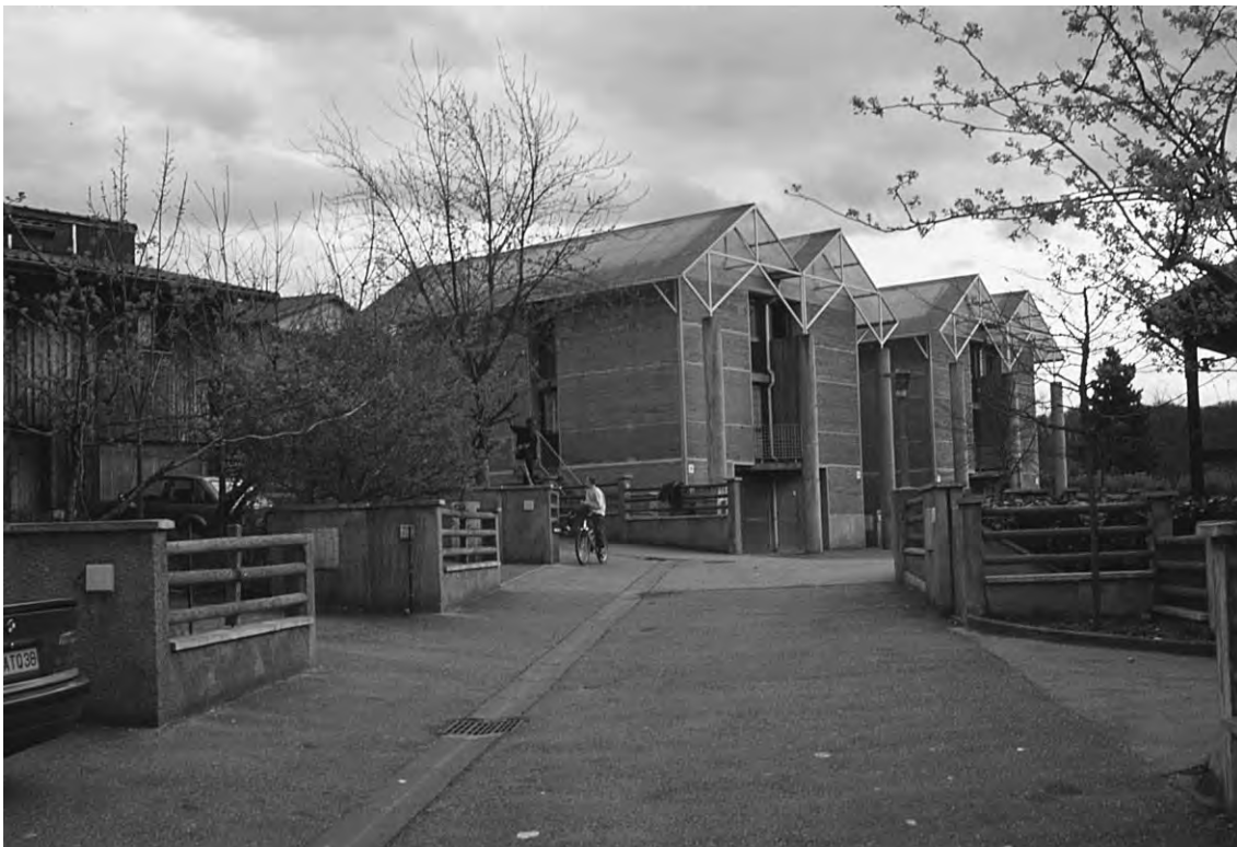
Fig 5.34. Två trevåningshus av arkitekterna Françoise Jourda och Gilles Perraudin av stampad lerjord. Under den dubbla sadeltakskonstruktionen har värmepumpar dolts.
