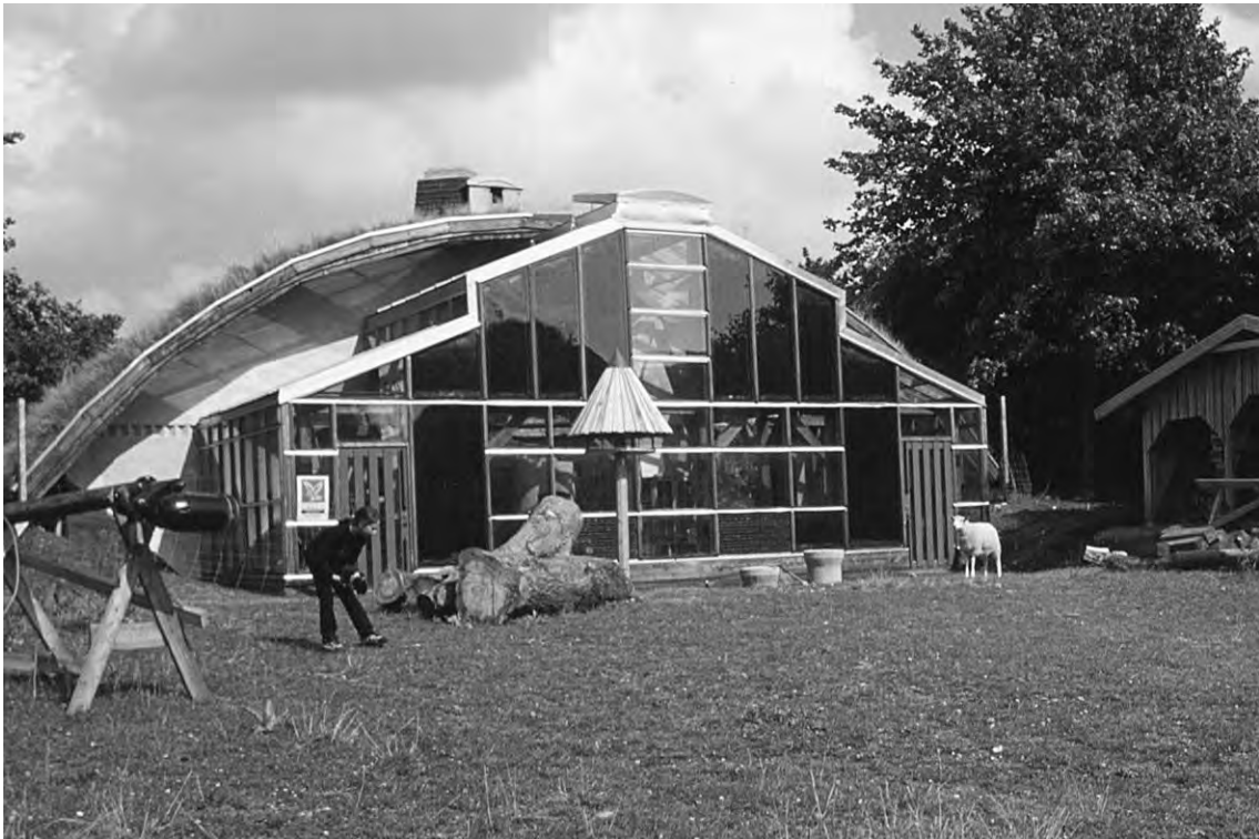
Fig 4.24. Den sydvända fasaden med integrerad solfångare och solceller.
