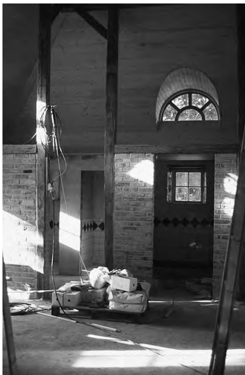
Fig 4.7, 8. Samma utrymme med ett års mellanrum. De kraftiga stolparna som bär upp den separata takkonstruktionen har tjänat som virke i den gamla, numera rivna, teatern i Falkenberg. Även teglet, som använts till en del av innerväggarna, kommer från samma byggnad. Detta är nog STF:s finaste sanitetsanläggning då denna och passagen till huvudbyggnaden också tjänar som konstgalleri.
