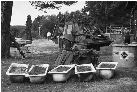
Fig 4.38. Leran förbereddes med att läggas i blöt ett par dagar i ett antal badkar som lånats från lantgårdarna runt om i trakten.
