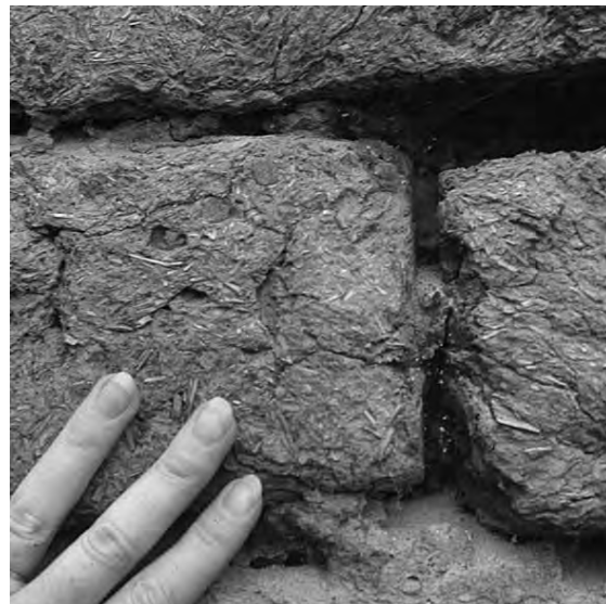
Fig 6.7. Lerstenarna vid spannmålsmagasinet vid Gudhammars herrgård innehåller stor mängd träspån och har klarat fuktens inverkan bättre än lerbruket i murfogarna.
