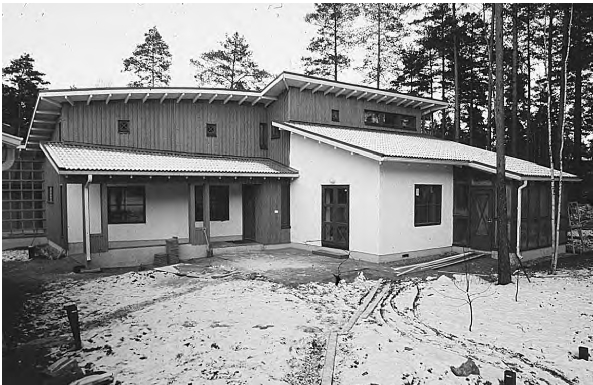
Fig 5.2. Under bomässan i Raisio 1998 uppfördes detta hus som ritats av arkitekt Teuvo Ranki. Huset är byggt med en bärande konstruktion av trä som isolerats med lerhalmblock med måtten 150 x 400 x 600 mm. Dessa prefabricerades av Timo Lehtonen.
