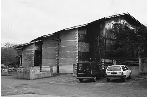
Fig 5.35. Stampjordshus ritat av arkitekt Jean Vincent Berlottier. Byggnaden innehåller fyra lägenheter och har runda trapphus mot norr
