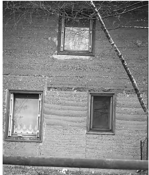
Fig 5.39. När detta stampjordshus uppfördes byttes entreprenör mitt i arbetet. Den underdelen har byggts med korta klätterformar, den övre med långa. Här syns tydligt att olika hantverkare hanterar byggmetoden mer eller mindre skickligt.
