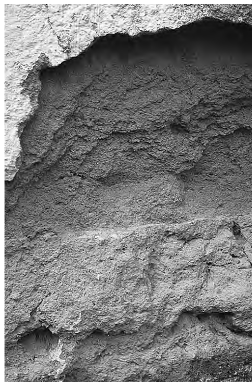
Fig ii07, 0005-257. En bit skadad mackelerad yttervägg till en mellansvensk ladugård som uppfördes 1886. Här syns skiften tydligt. Sommartid släpps kalvar ut i den intilliggande hagen och föredrar att slicka i sig av väggen istället för den saltsten som djurskötaren lägger fram. Kan det månne ha berott på lerans mineralsammansättning?
