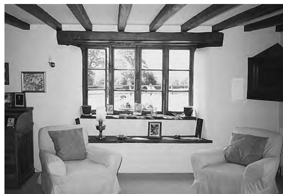
Fig 24. Fönsteröppning i engelskt mackelerat hus, Down St Mary. Lägg märke till den mjukt formade nischen och den inbyggda hyllavsatsen.
