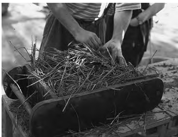
Fig 56, 57. En enkel form packas med lerhalm. Blocket bör framställas på en platta vilket gör att man inte behöver ta i det med händerna, och därmed riskera att det deformeras, när det ska förflyttas till torkplatsen.
