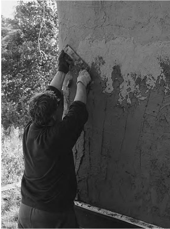
Fig 72. Ett lager puts strykes på ett hus med, isolerande väggar av halm, med ett bräde. Vid putsningen trycks lermassan på med viss kraft, men får inte bearbetas för länge vilket kan göra att den lossnar från underlaget.
