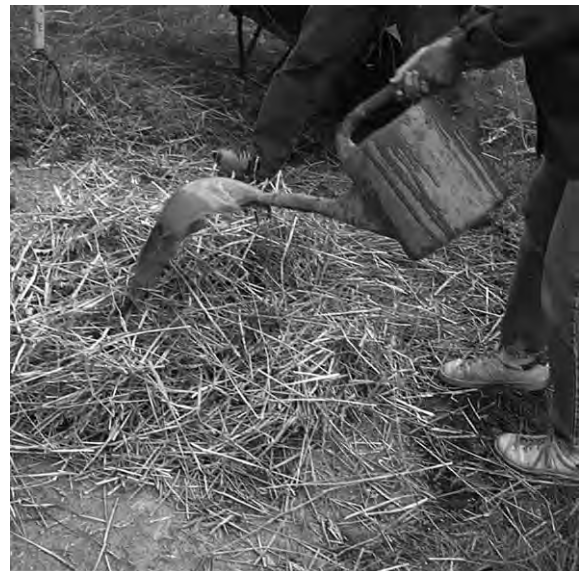
Fig 50. Lervälling och vatten ska blandas samman. Vid detta självbyggeri strilas lervattnet över halmen med en vattenkanna som försetts med en matsked i pipen.
