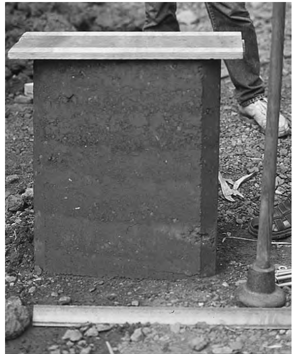
Fig 15. Formen från fig 12 är avtagen. Den nystampade murbiten har en lätt fuktad yta som snabbt torkar medan de inre delarna kan behöva ett år för att bli genomtorra. Skiften syns som ränder. Stampväggens hållfasthet varierar inom varje skift och är starkast på ytan som träffas av stampverktyget, vilket inte har någon betydelse för murens hållfasthet i stort. 52 (Ett sätt att få en jämnare fördelning av jordmassan i formen är att skyffla vartannat spadtag mot inner respektive ytterformen.)
