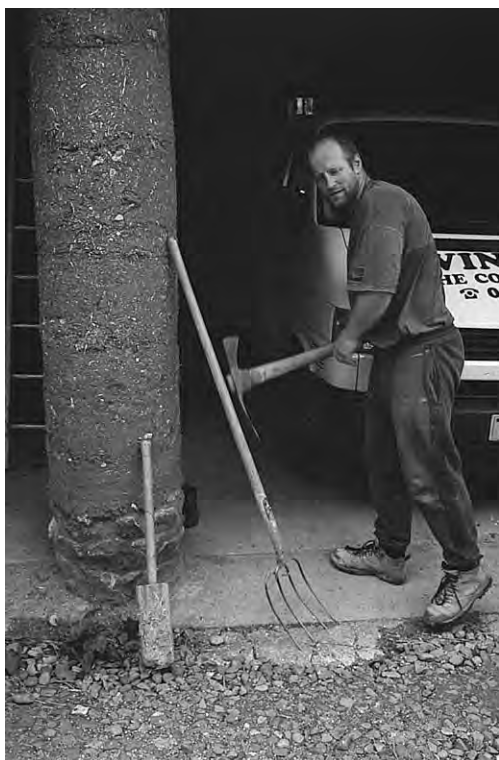
Fig 6. Kevin McCabe i England demonstrerar de verktyg som han använder när han bygger mackelerade väggar. En grep till att förflytta lermassan, en hacka att jämna till vägen och en klamp för att ytterligare komprimera ytan. Stolpen är byggd i denna teknik och tar en last på 2 ton. Enligt McCabes beräkningar skulle den klara 20 ton.
