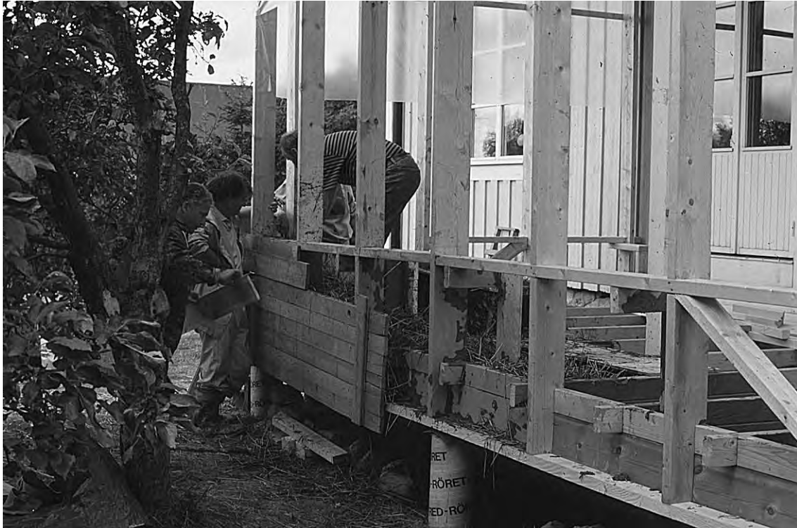
Fig 54. Packning av lerhalm i klätterform. Till verandan som byggdes in behövdes inte djupare vägg än djupet på reglarna. Formen sätts fast vid reglarna med skruv och flyttas vartefter väggpartiet packas.
