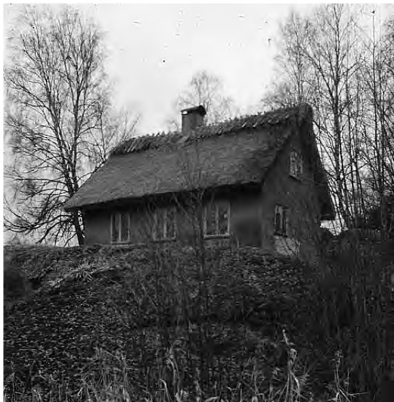
Fig 43. Litet hus på sörmländsk gård med lerhalmisolerering och halmtak, uppfört 1995 - 1996.
