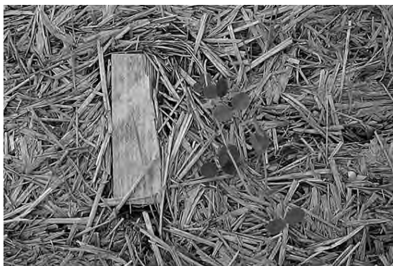
Fig 51. Det är liv i väggen! Men det är ingen fara, groddarnas rötter hjälper till att suga ut vatten ur väggen. Här har ett ogräsfrö slagit rot.
