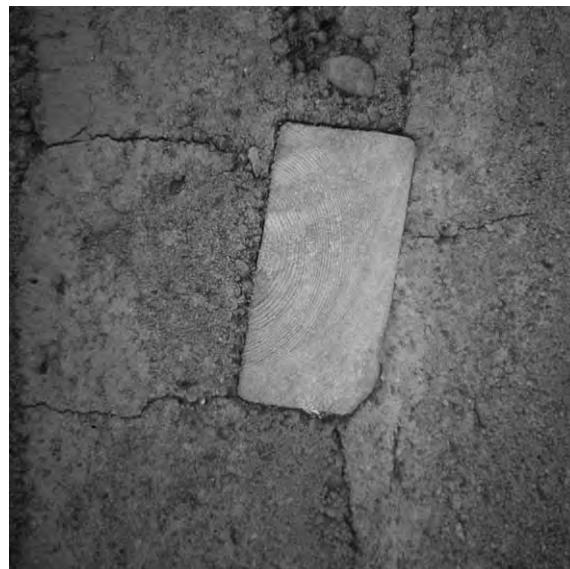
Fig 23. Det är inte nödvändigt att bygga in sidstyckena i dörr- eller fönsteröppningar när murarna stampas. Det kan rent av vara bra att vänta med att montera dessa om det befaras att byggnaden kommer att sätta sig. Ett förfarande är att stampa in träklossar som dörr- eller fönsterkarmar sedan kan monteras mot. Enligt traditionen ska klossarna vara koniska med den smalare sidan utåt.
