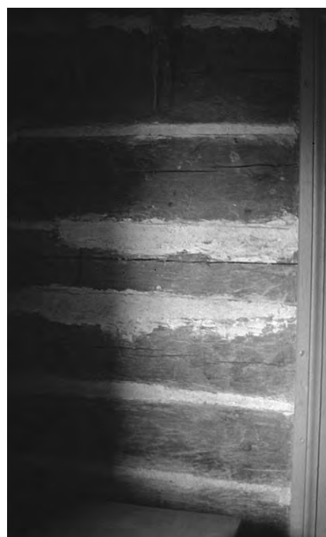
Fig 58. I köket i Linnés Hammarby utanför Uppsala har väggarna tätats med lerbruk.
