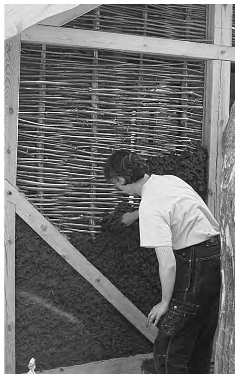
Fig 60. Pågående lerklining av byggnad av ramverkskonstruktion.
