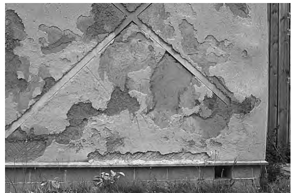
Fig 70. Här har det inte gått så bra med den utvändiga lerputsens. Finputsens tagit med sig stora delar av utstockningen, och på sina håll även grundningen. Det troliga är att det yttersta lagret med finputs innehöll en fetare blandning i förhållande till de undre lagren. En viss reduktion av skadeverkningarna hade troligen kunnat ske om väggen hade fuktats ordentlig innan finputsens lades på, så gjorde aldrig. Byggaren har nu tagit det säkra före det osäkra och försett sitt hus med en träfasad med luftspalt.
