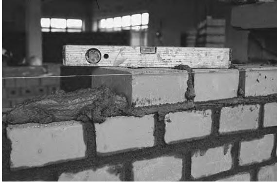
Fig 34. Murning av lersten följer samma principer som tegelmurning och murarens viktigaste hjälpmedel är, förutom murhammare och murslev, vattenpass och snöre.
