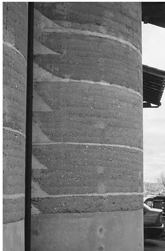
Fig 19. Det finns många sätt att göra hörnförstärkningar på. Här har kalkbruk lagts i triangulära skift, vilket ger byggnaden en arkitektonisk särprägel.
