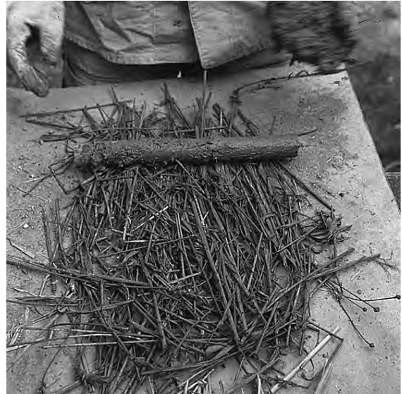
Fig 62. Principen för en vickel. En träpinne viras med lerhalm och lerbruk till en jämn stav som kan läggas i golv- och mellanbjälklag, i utfackningar eller som avbalkning ovanför en dörr- eller fönsteröppning.
