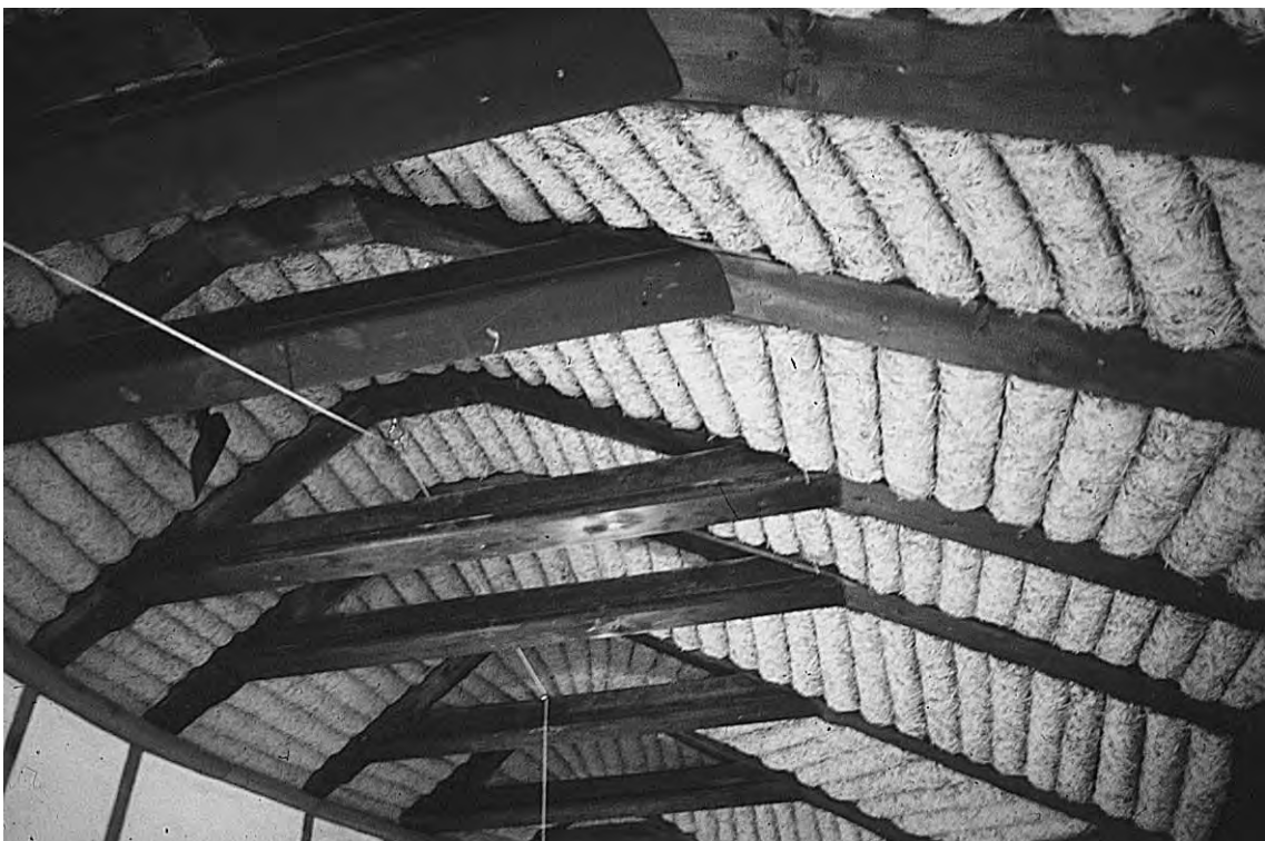
Fig 63. Innertak vid Solviksskolan i Ytterjärna, där vickler ger ett arkitektoniskt uttryck.
