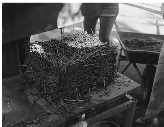
Fig 56, 57. En enkel form packas med lerhalm. Blocket bör framställas på en platta vilket gör att man inte behöver ta i det med händerna, och därmed riskera att det deformeras, när det ska förflyttas till torkplatsen.
