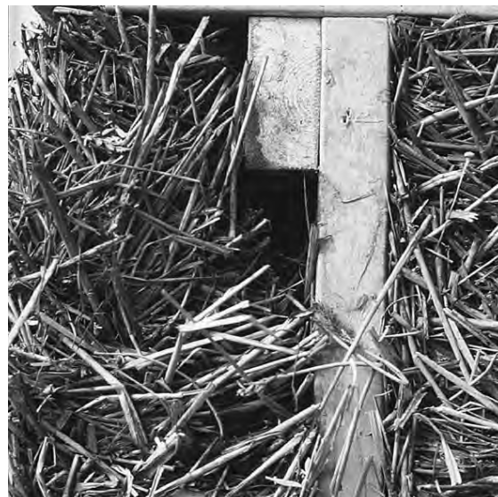
Fig 52. Inga hål får förekomma i isoleringen i en lerhalmsvägg. Vid nedkylning kan den relativa fuktigheten bli riskabelt hög så att vatten kondenseras i dessa håligheter. Risken finns då att mikrobiell tillväxt äger rum, vilket kan leda till att väggmaterialet bryts ner. När väggen är helt torr måste därför hål och springor fyllas igen med lerhalmsmassa.
