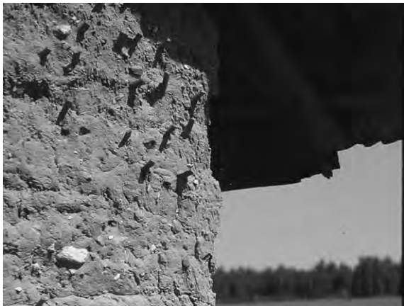
Fig 67. Mackelerat hus i Estland som en gång försetts med puts. Träplugg har då använts för att ge putslagren ordentligt fäste.
