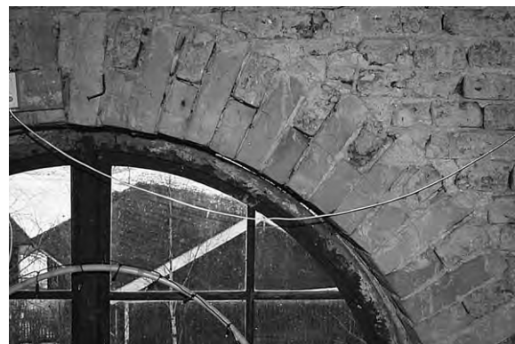
Fig 37. I det gamla vallonbruket Svalbo, i Järle, har känsliga partier förstärkts med tegel, vilket också kan ge arkitektoniska effekter.
