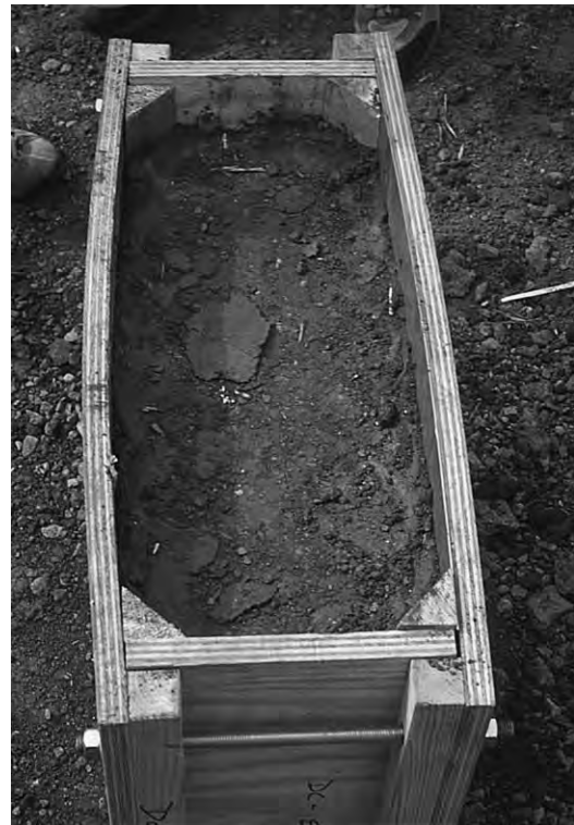
Fig 12. Bilden visar en demonstration av hur en form kan se ut och hur jordväggen stampas. Lägg märke till att hörnorna är avfasade för ökad hållbarhet. Trots det korta avståndet mellan gavelstyckena och stampning för hand buktar formens plywoodskivor ut.
