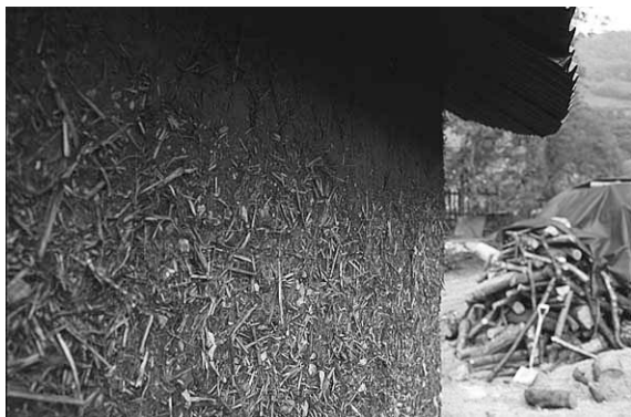
Fig 4. Under takutsprånget har väggen klarat sig bättre än nedanför, där den utsätts för vatten och vind. Bilden är tagen i England fyra år efter det att byggnaden uppfördes.
