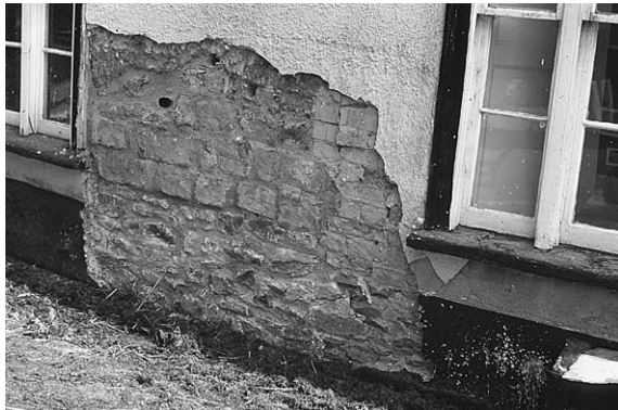
Fig 13. Delar av detta engelska mackelerade hus i Payhembury, är 300 år gamla och en bärande yttervägg som fuktskadats har lagats med block. Lägga märke till ventilationshål i väggen där en större mängd lerbruk har lagts in. Grundmuren kan ha olika höjd och består här av natursten som går ända upp till fönsterbröstningen.
