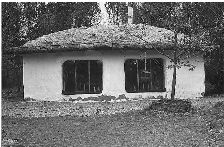
Fig 4. Under takutsprånget har väggen klarat sig bättre än nedanför, där den utsätts för vatten och vind. Bilden är tagen i England fyra år efter det att byggnaden uppfördes.
