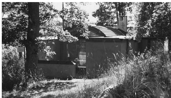
Fig 10. Prototypen som blev ett experimenthus med ekologiska byggmaterial vid Mauritzbergs slott.
